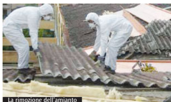
La rimozione dell'amianto
