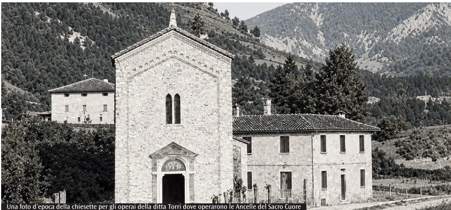
Una foto d'epoca della chiesette per gli operai della ditta Torri dove operarono le Ancelle del Sacro Cuore
