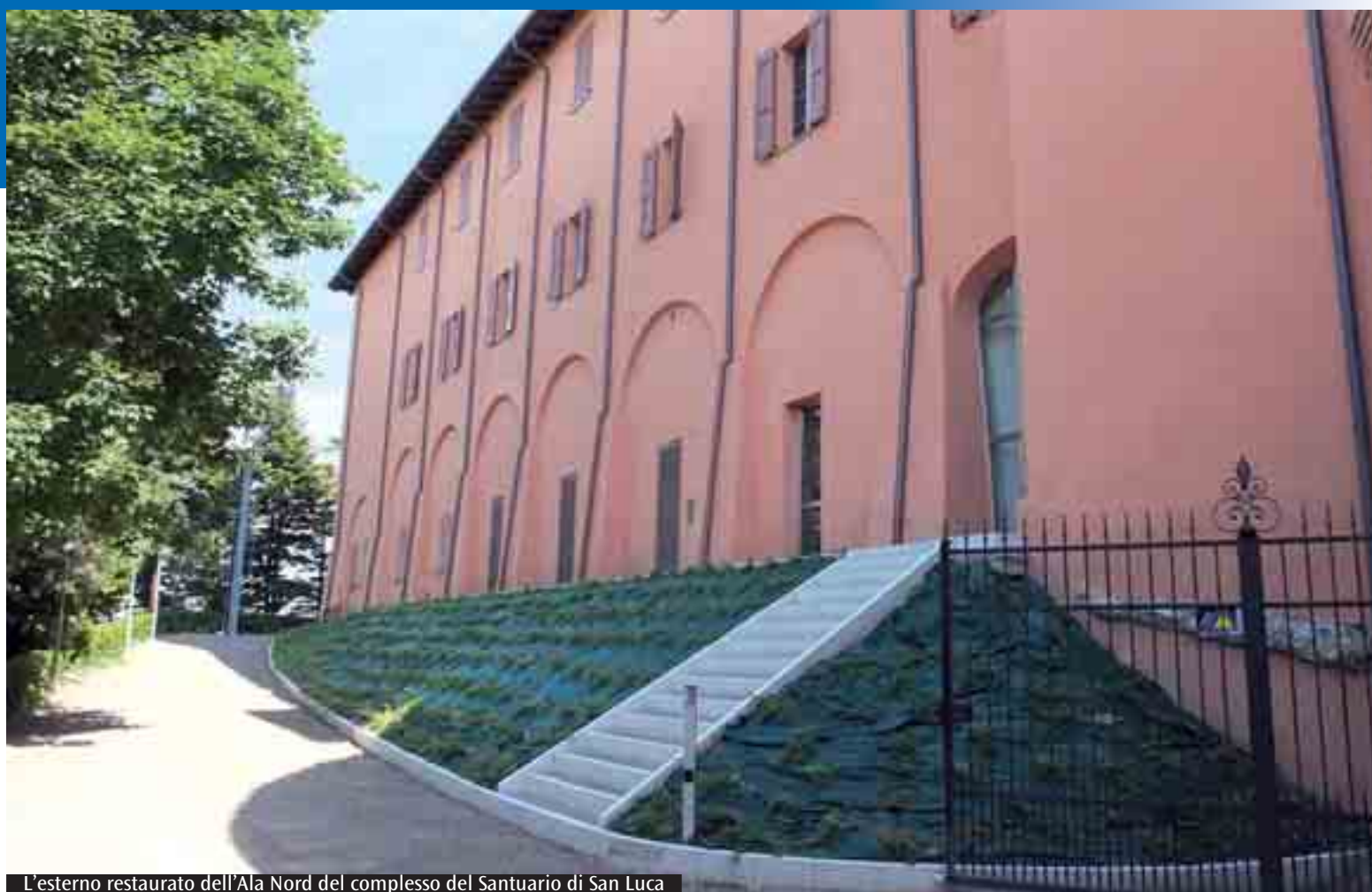
L'esterno restaurato dell'Ala Nord del complesso del Santuario di San Luca
