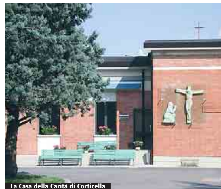
La Casa della Carità di Corticella
