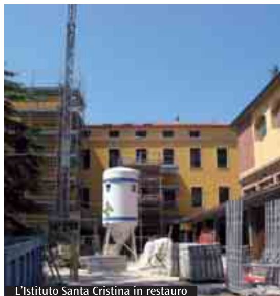
L'Istituto Santa Cristina in restauro
