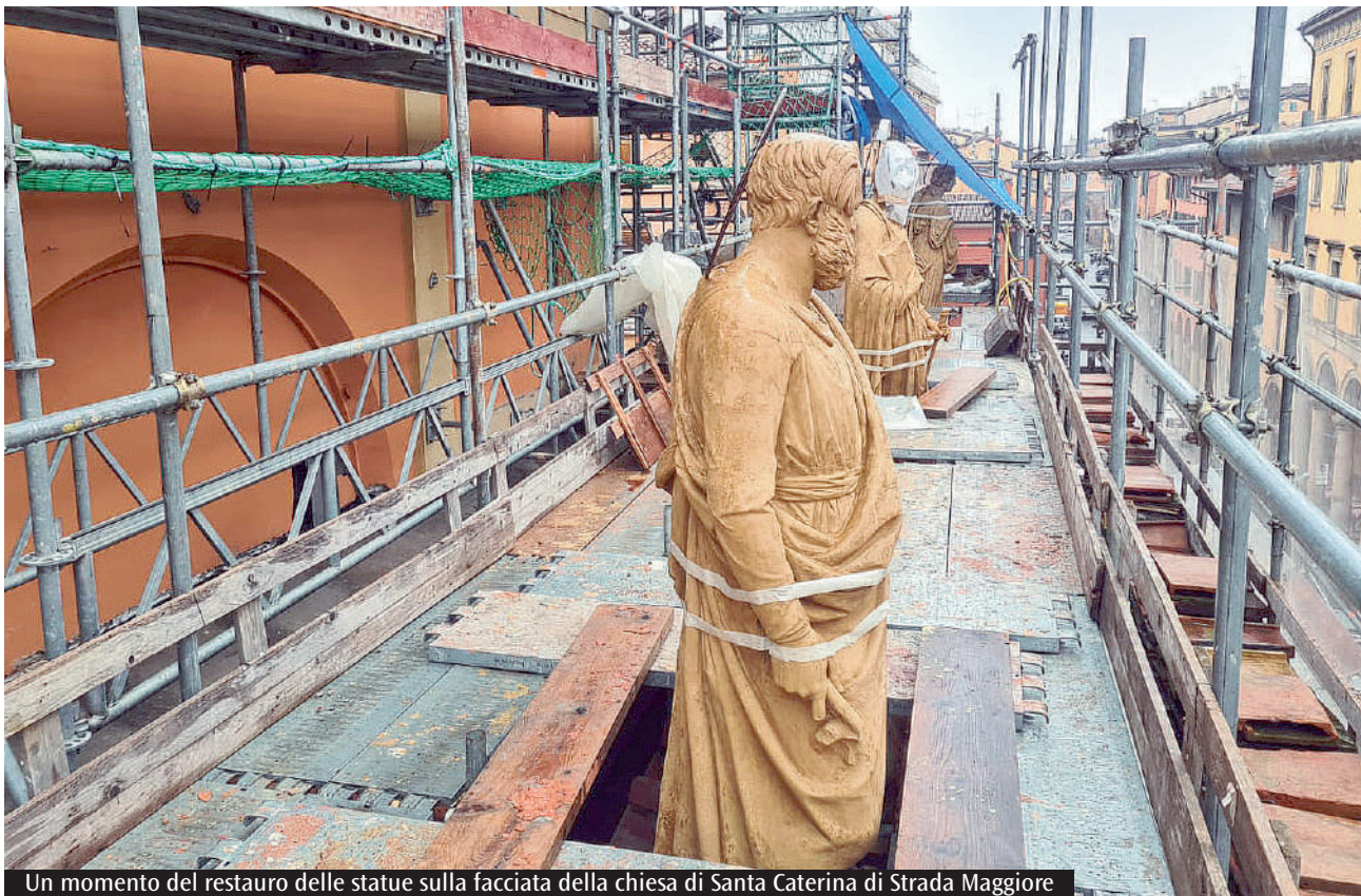
Un momento del restauro delle statue sulla facciata della chiesa di Santa Caterina di Strada Maggiore
