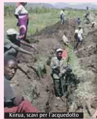
Kiirua, scavi per l'acquedotto
