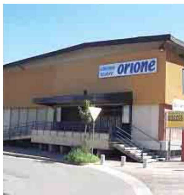
Veduta esterna del cinema-teatro Orione
