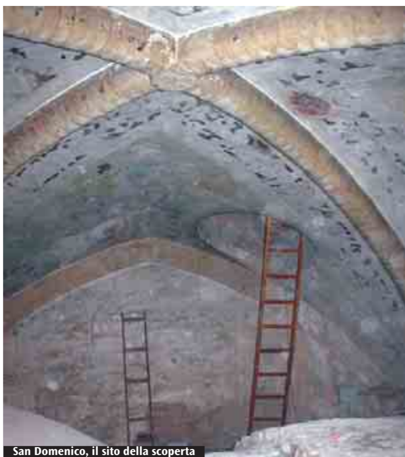
San Domenico, il sito della scoperta
