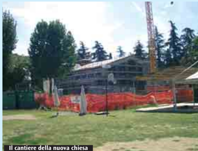
Il cantiere della nuova chiesa
