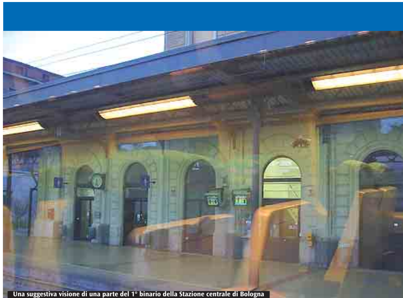
Una suggestiva visione di una parte del 1° binario della Stazione centrale di Bologna
