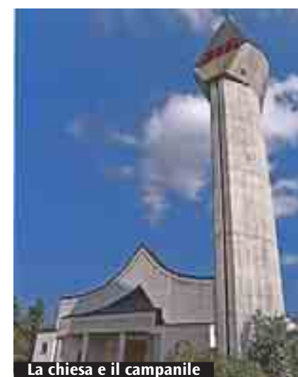
La chiesa e il campanile
