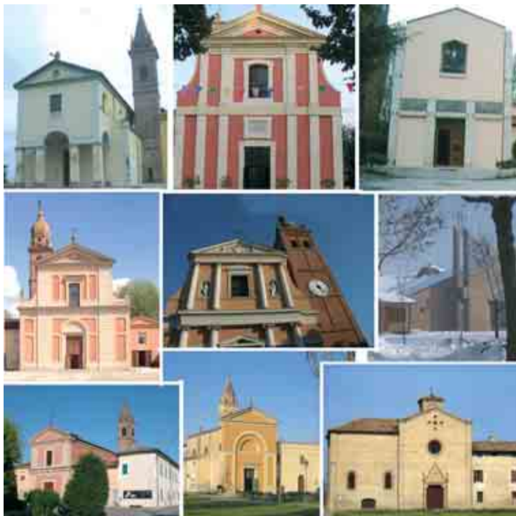
Nella foto dall'alto a sinistra in senso orario le chiese di Amola, Castagnolo, Lorenzatico, San Camillo, Madonna del Poggio, Tivoli, Zenerigolo e Le Budrie. Al centro la Collegiata di San Giovanni in Persiceto.
