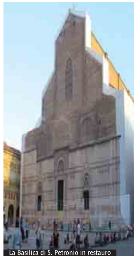
La Basilica di S. Petronio in restauro
