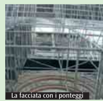
La facciata con i ponteggi
