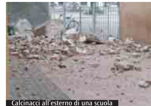
Calcinacci all'esterno di una scuola
