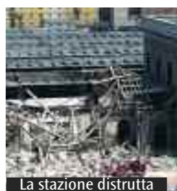
La stazione distrutta
