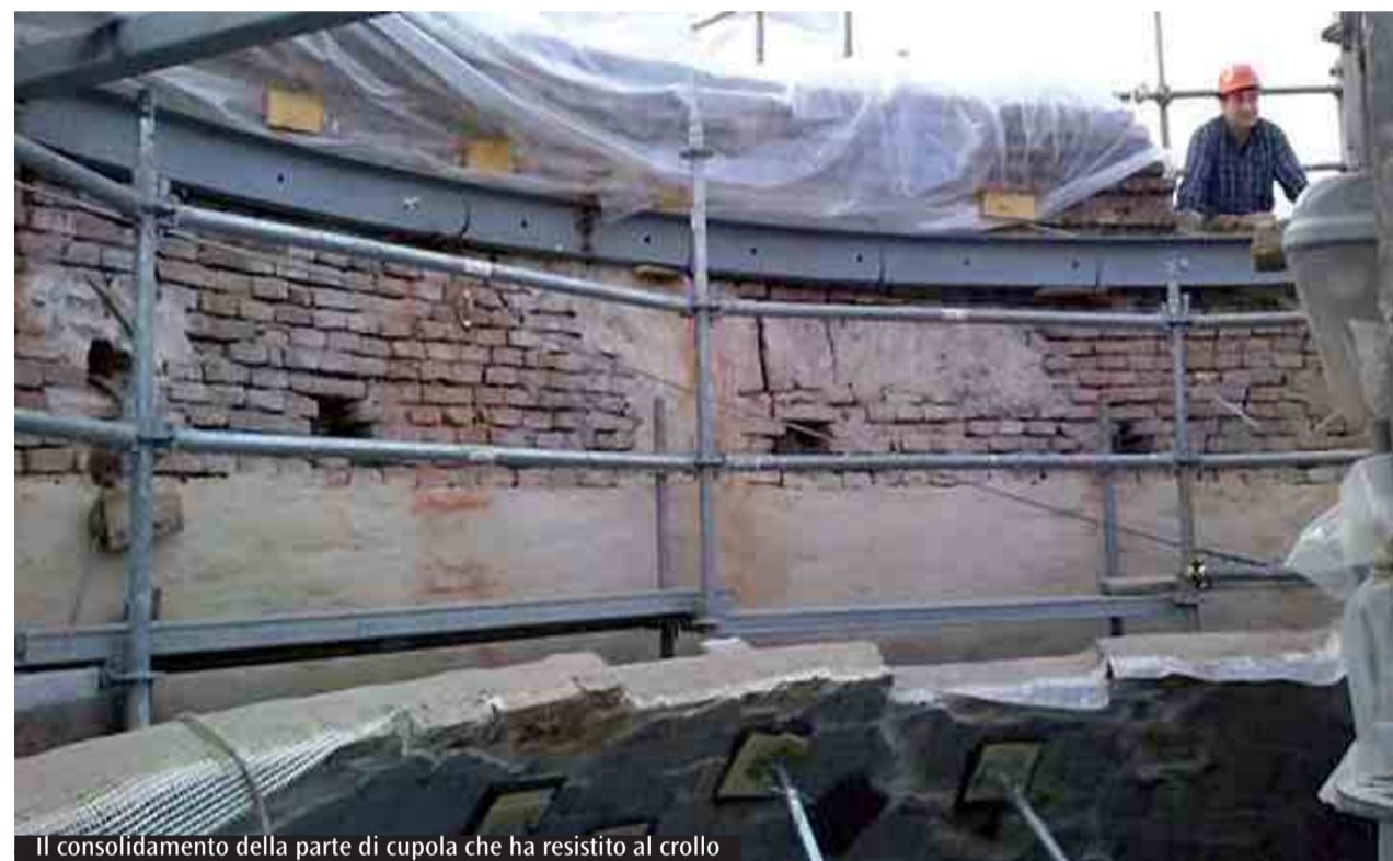
Il consolidamento della parte di cupola che ha resistito al crollo
