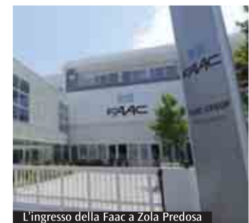
L'ingresso della Faac a Zola Predosa
