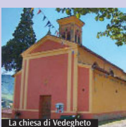
La chiesa di Vedeghetto
