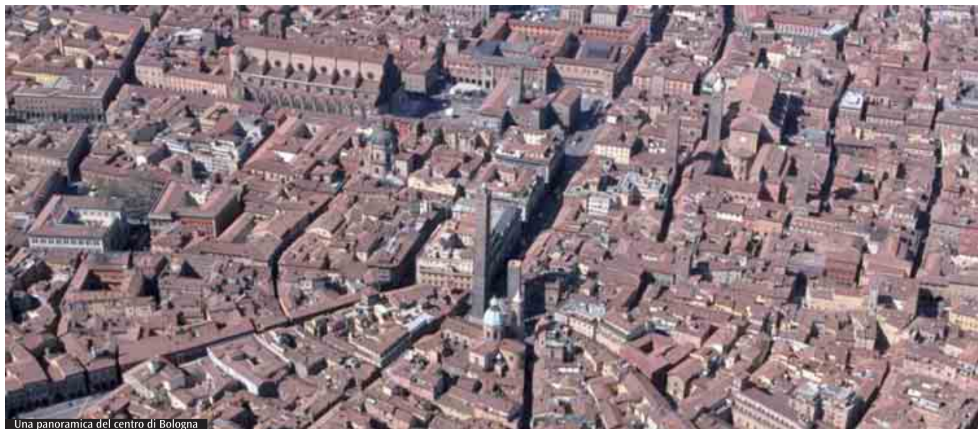
Una panoramica del centro di Bologna
