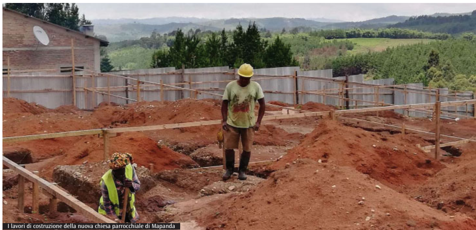
I lavori di costruzione della nuova chiesa parrocchiale di Mapanda
