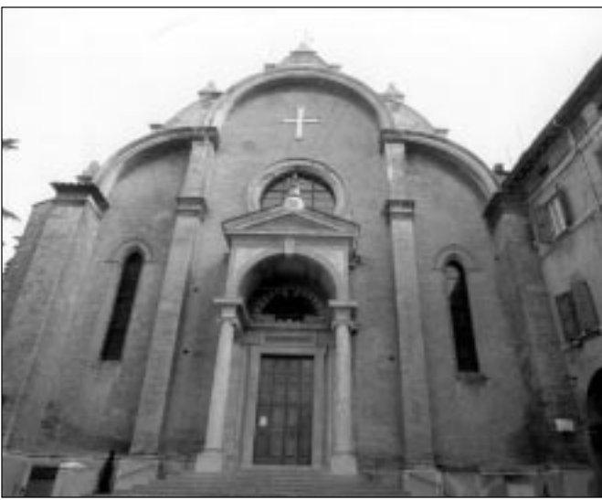
La facciata di S. Giovanni in Monte prima del restauro
