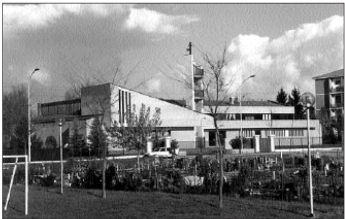
Il complesso delle opere parrocchiali di S. Antonio da Padova alla Dozza
